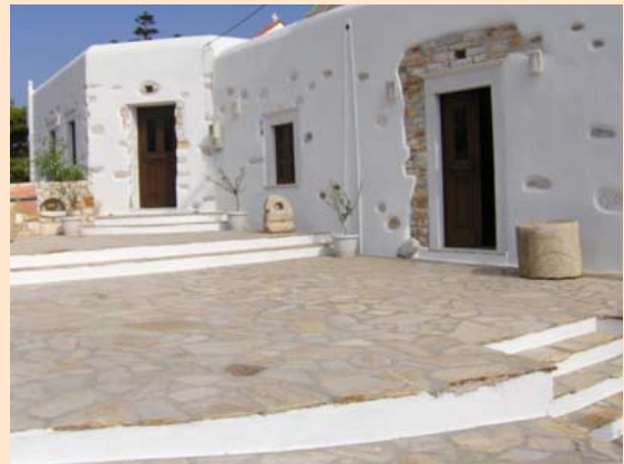
Réhabilitation d'un moulin à huile et création du musée de l'olive
