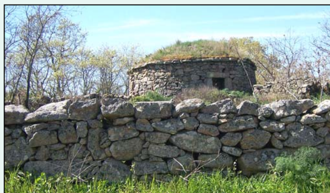
Patrimoine pierre sèche à Castelo do Vide
